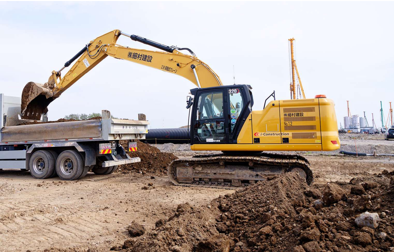
荒川調節池の現場で稼働するCat 320。
