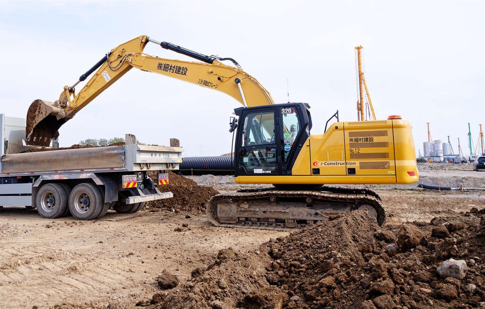
荒川調節池の現場で稼働するCat 320。
